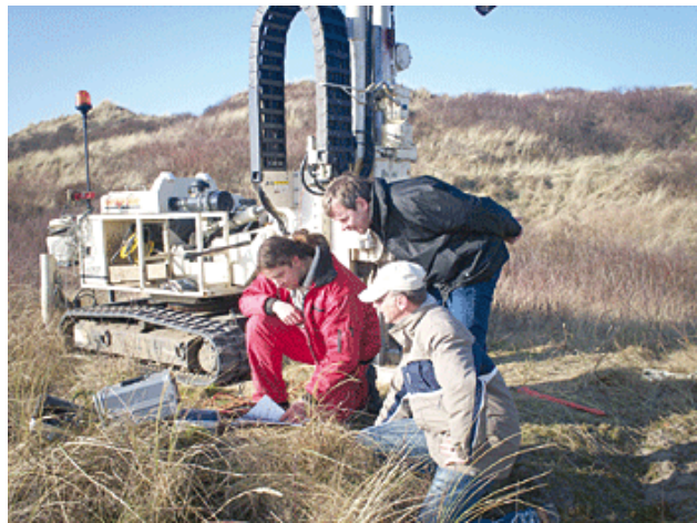
Bei den Arbeiten im Borkumer Osten.
